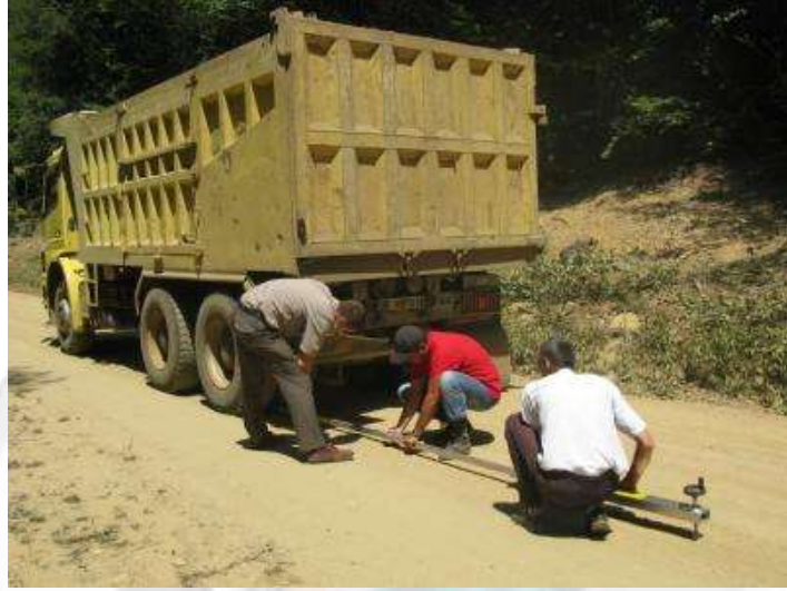
Şekil 3: Benkelman beam ile yapılan ölçümler
