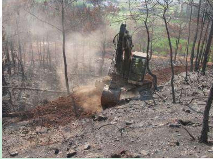
Şekil 2: Ekskavatör ile sürütme yollarının açılması
